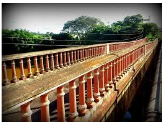
Figura 3.2.1: Ponte dos Boiadeiros
