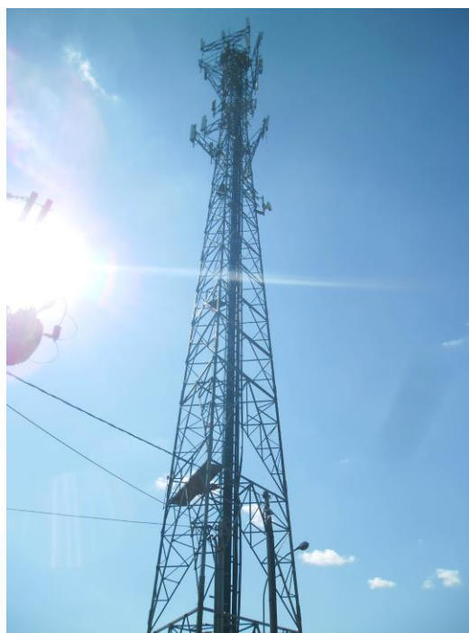
TORRE DE TELECOMUNICAÇÃO
