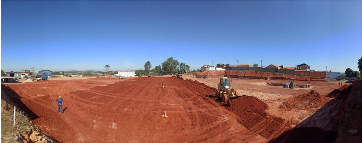
9.1.5 - Foto 05 – Vista do terreno a ser implanta o empreendimento – data 02/07/2021
