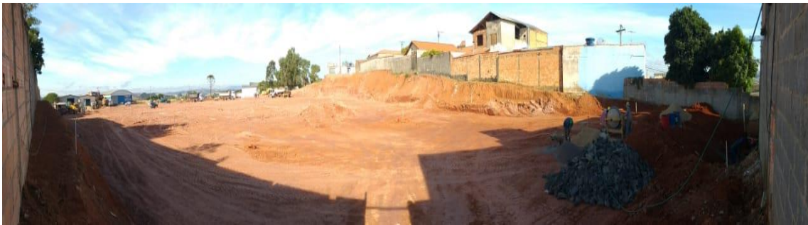
9.1.6 - Foto 06 – Vista fundos do terreno – data 02/07/2021
