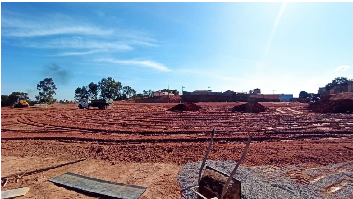
9.1.2 - Foto 02 – Início da terraplanagem – data 02/07/2021
