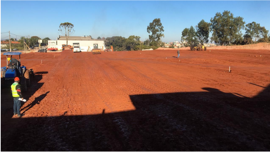
9.1.8 - Foto 08 – terraplanagem em execução – data 02/07/2021
