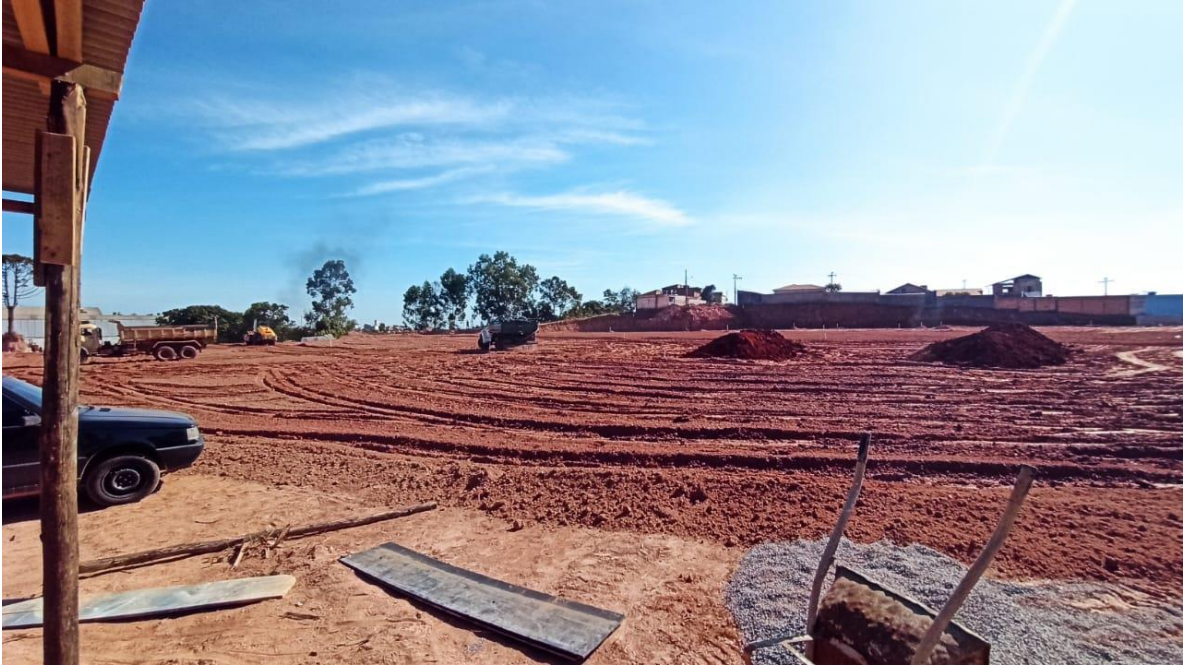
9.1.1 - Foto 01 – Início da terraplanagem – data 02/07/2021
