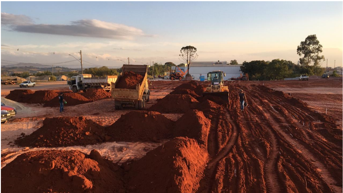
9.1.3 - Foto 03 - Chegada de material para aterro – data 02/07/2021
