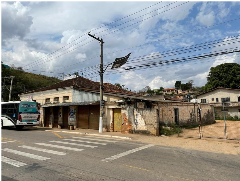
Foto 02 – Fachada atual do futuro local de implantação de posto de combustíveis – data 02/10/2022
