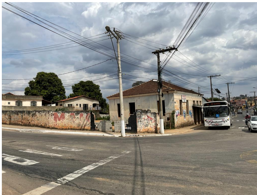
Foto 05 - Vista do local de futura implantação de posto de combustíveis - data 02/10/2022
