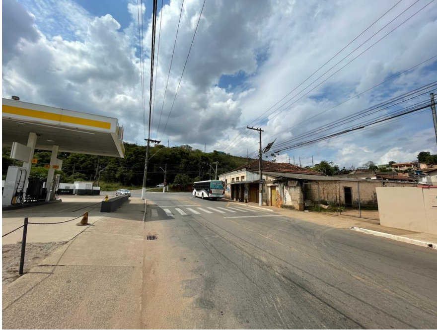
Foto 01 – Vista do local de futura implantação de posto de combustíveis - data 02/10/2022
