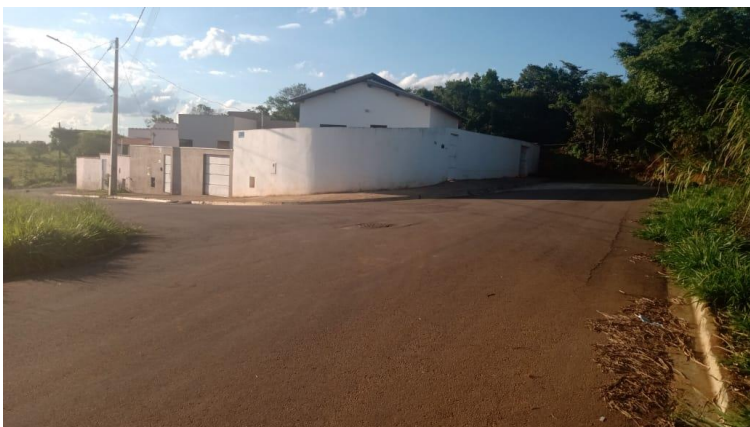
IMAGEM 20: Detalhe Curva Esquerda Acesso Av. dos Inconfidentes para Rua Mônaco
